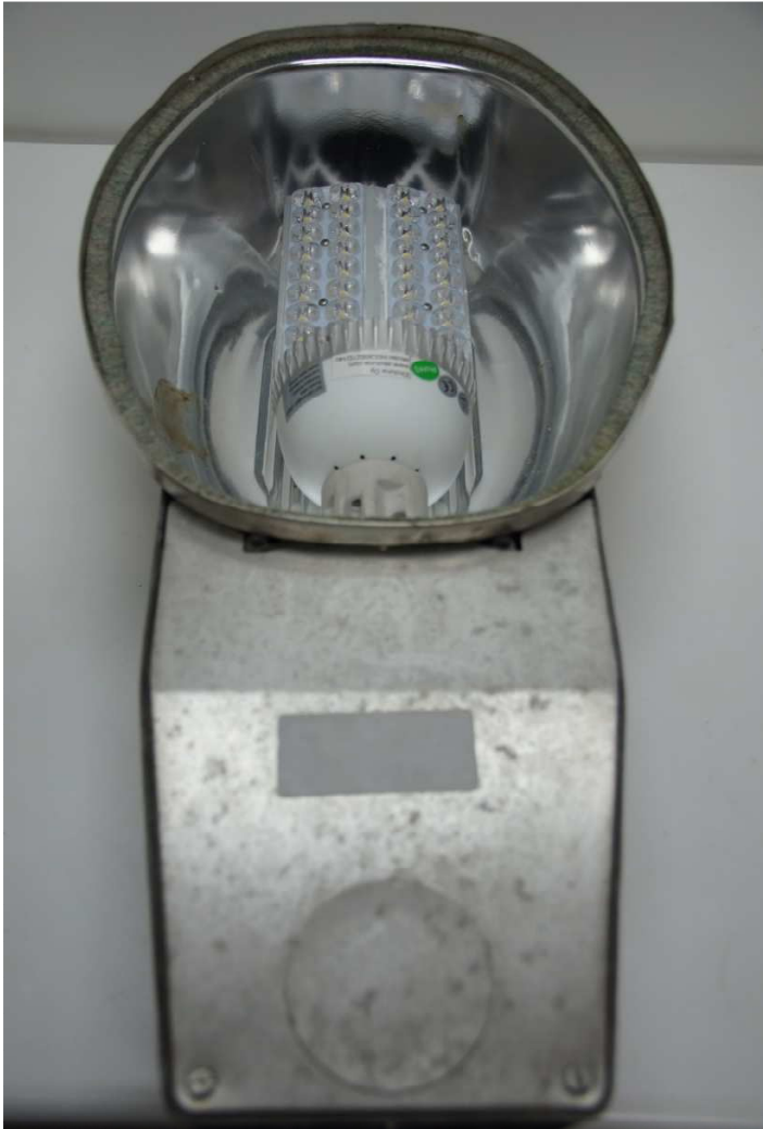
Lusikkamallin valaisin. 125w elohopeahöyrypolttimo korvattuna 36 watin led-polttimolla
